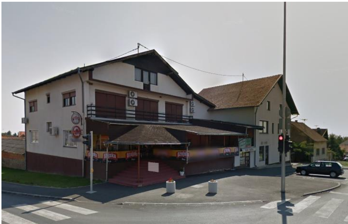
SLIKA 3: GRAĐEVINA P+2 U NASELJU KAPTOL
